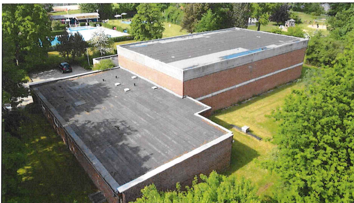
Sporthalle, Luftbild (Quelle: Quartierskonzept Abschlussbericht; https://www.grundschule-timmaspe.de , WDK Architekten + Ingenieure)
