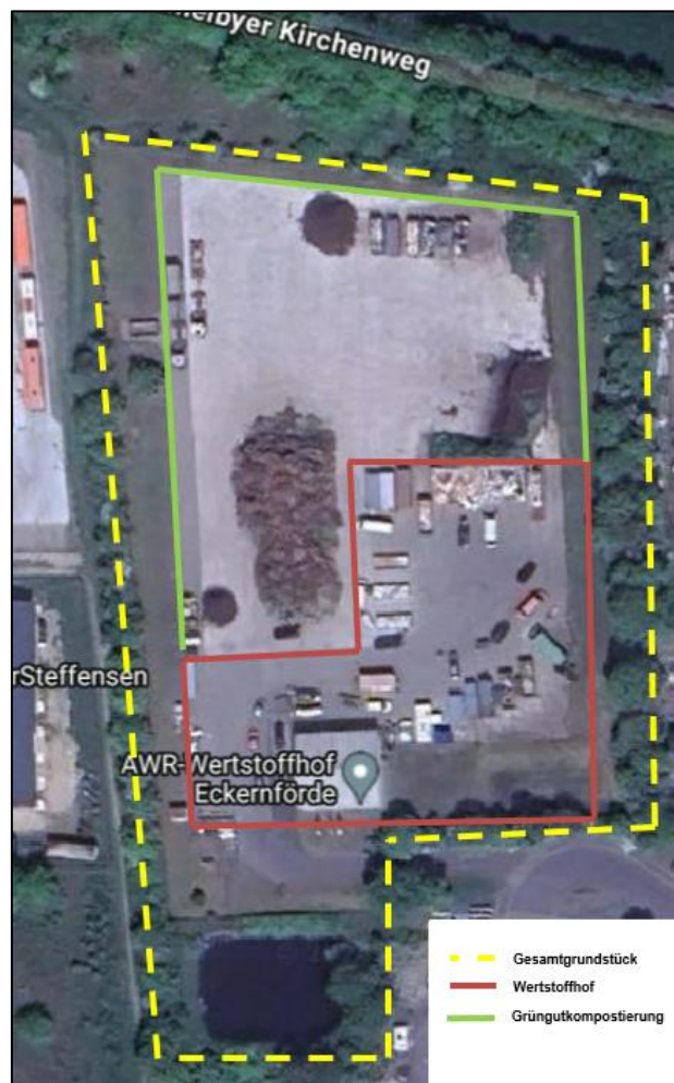
Abbildung 1: Luftbild Wertstoffhof und Kompostierungsanlage
