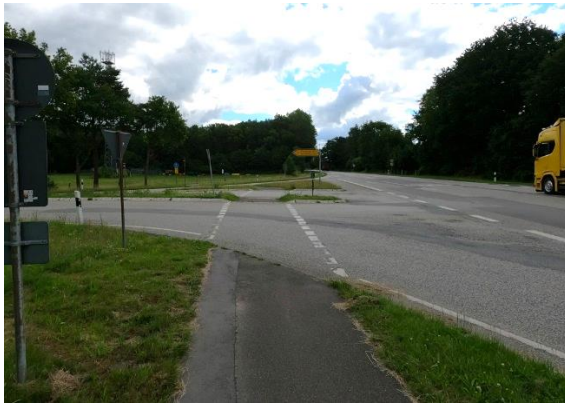
Abbildung 34: Unzureichende Furtmarkierung
