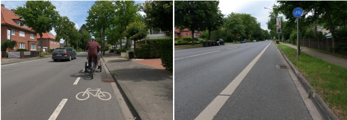
Abbildung 42: Innerörtlicher Schutzstreifen (links) und Radfahrstreifen (rechts)
