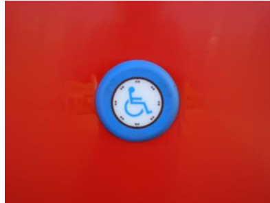
Abb. 2: Türöffner an 2. Tür (Zugang mit Klapprampe)
