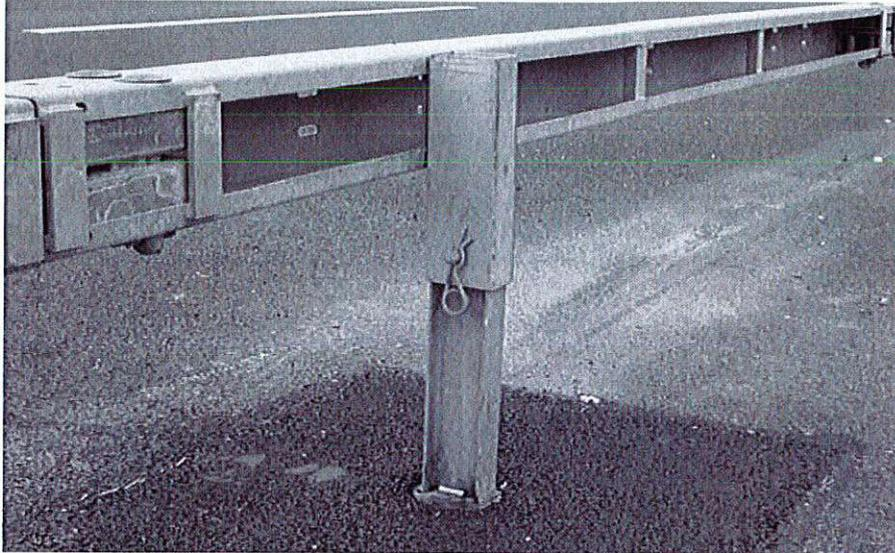
Bild 25: Schnell demontierbare Mittelleitplanken
