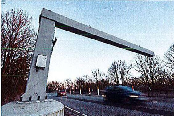
Bild 20: Höhenkontrolle und Induktionsschleife
