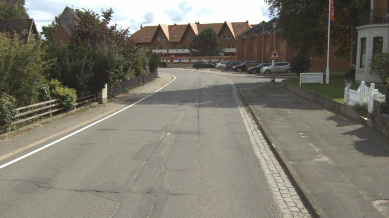
Straße: K58, Abschnitt: 1425004 - 1425007, Station: 173, Lage: R, FS: 1
