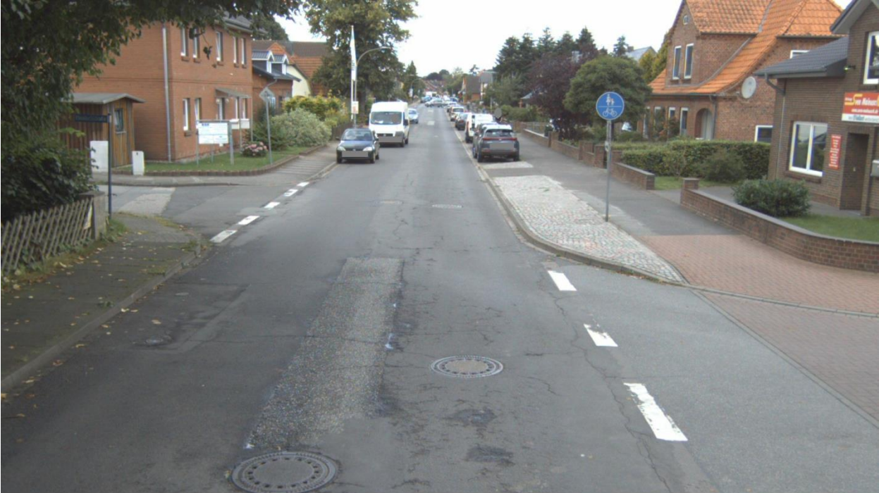
Straße: K99, Abschnitt: 1623031 - 1623013, Station: 5500, Lage: R, FS: 1
