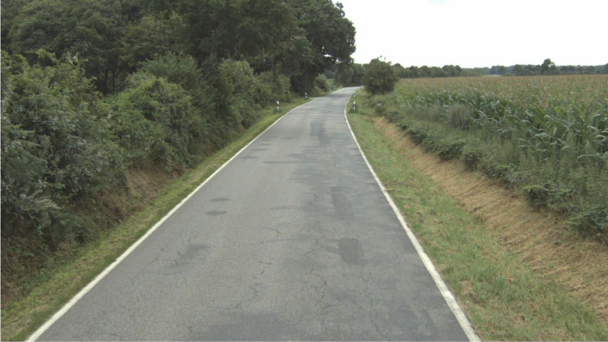
Straße: K26, Abschnitt: 1824009 - 1824008, Station: 7092, Lage: R, FS: 1
