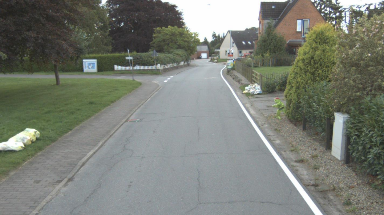
Straße: K53, Abschnitt: 1523021 - 1524012, Station: 4133, Lage: R, FS: 1
