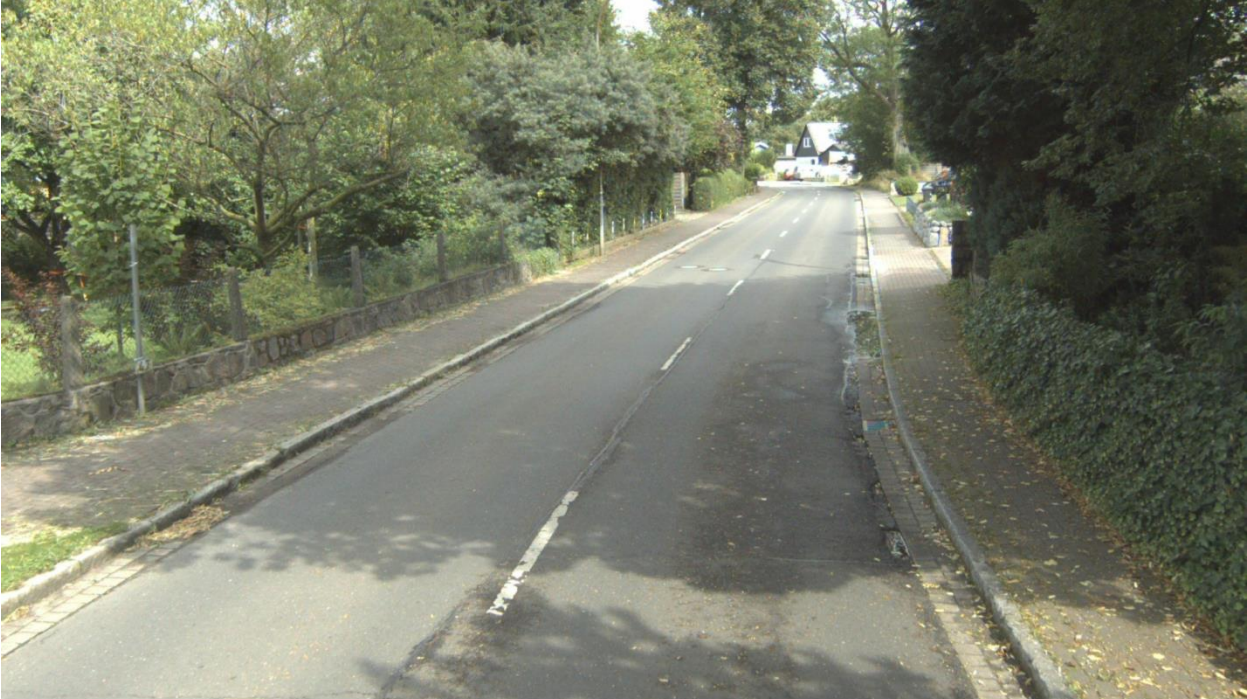
Straße: K75, Abschnitt: 1724002 - 1624020, Station: 1454, Lage: R, FS: 1
