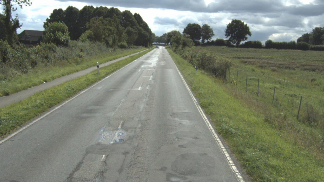
Straße: K49, Abschnitt: 1526009 - 1526022, Station: 830, Lage: R, FS: 1
