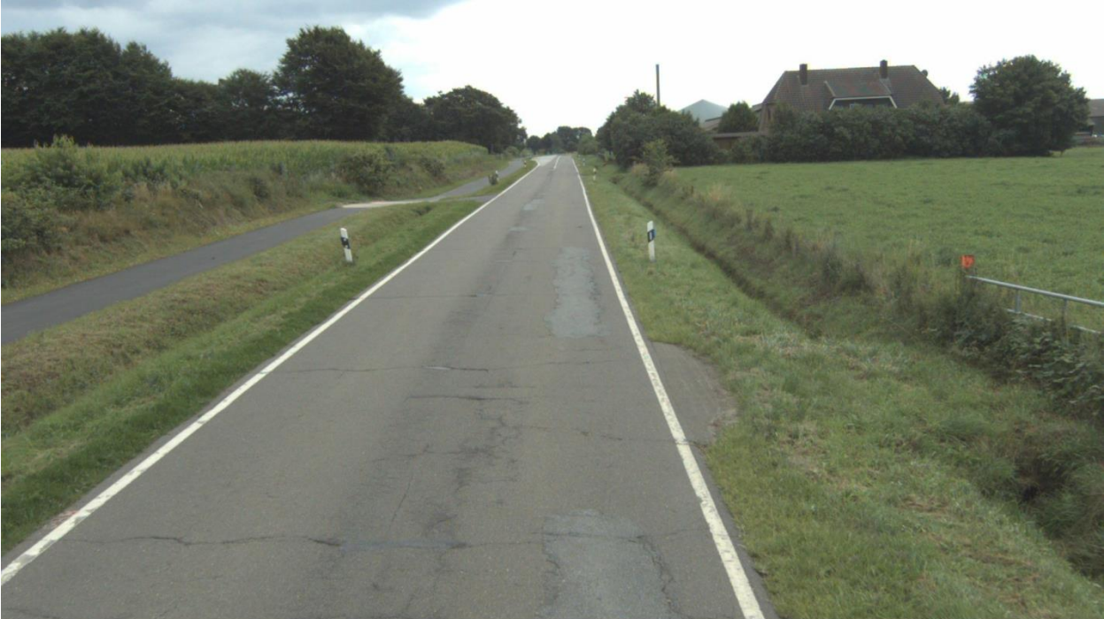
Straße: K43, Abschnitt: 1723016 - 1724013, Station: 1165, Lage: R, FS: 1
