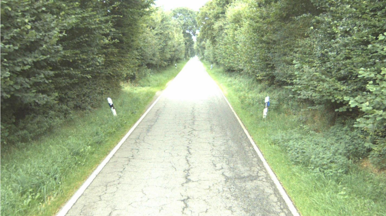
Straße: K36, Abschnitt: 1725008 - 1725005, Station: 3030, Lage: R, FS: 1
