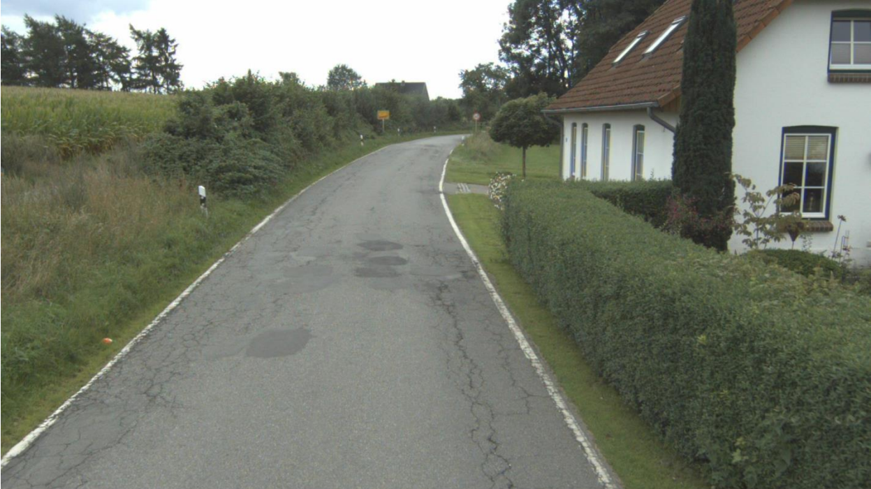
Straße: K92, Abschnitt: 1625004 - 1625006, Station: 742, Lage: R, FS: 1
