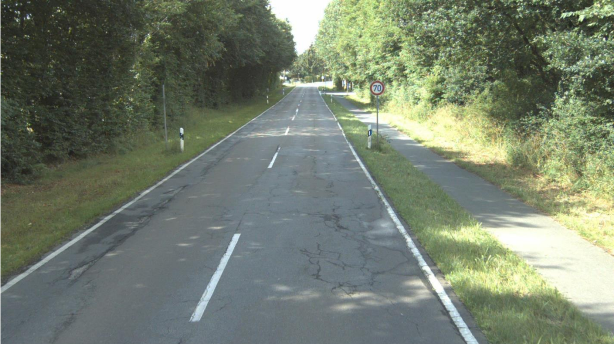
Straße: K27, Abschnitt: 1724013 - 1723008, Station: 4578, Lage: R, FS: 1
