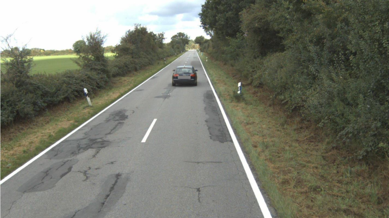
Straße: K86, Abschnitt: 1523012 - 1523019, Station: 1490, Lage: R, FS: 1
