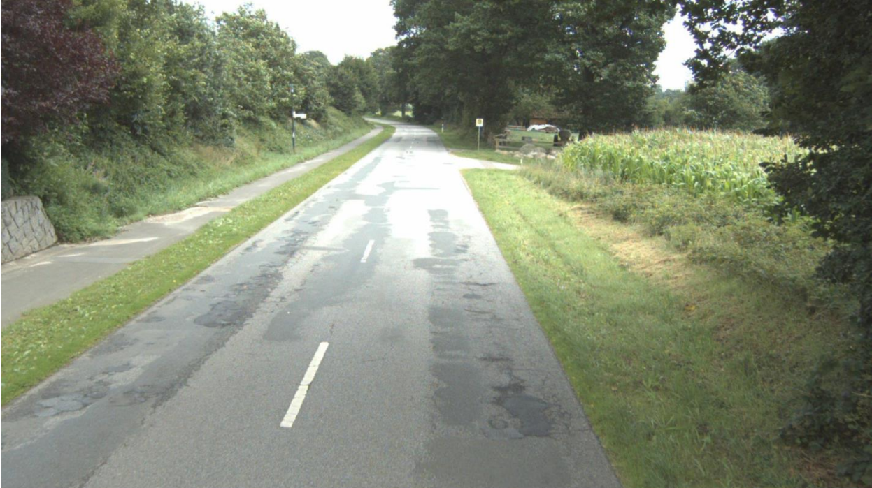
Straße: K26, Abschnitt: 1824009 - 1824008, Station: 480, Lage: R, FS: 1
