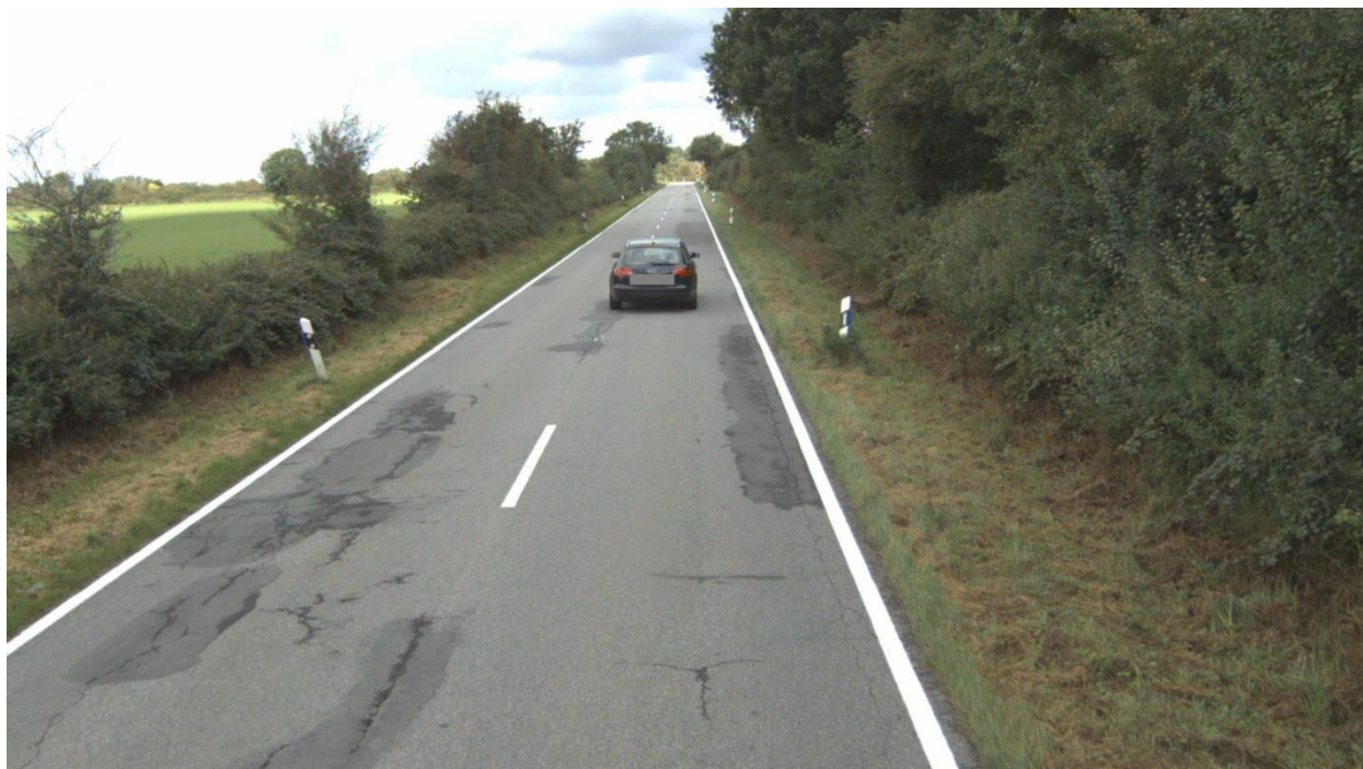
Straße: K86, Abschnitt: 1523012 - 1523019, Station: 1490, Lage: R, FS: 1
