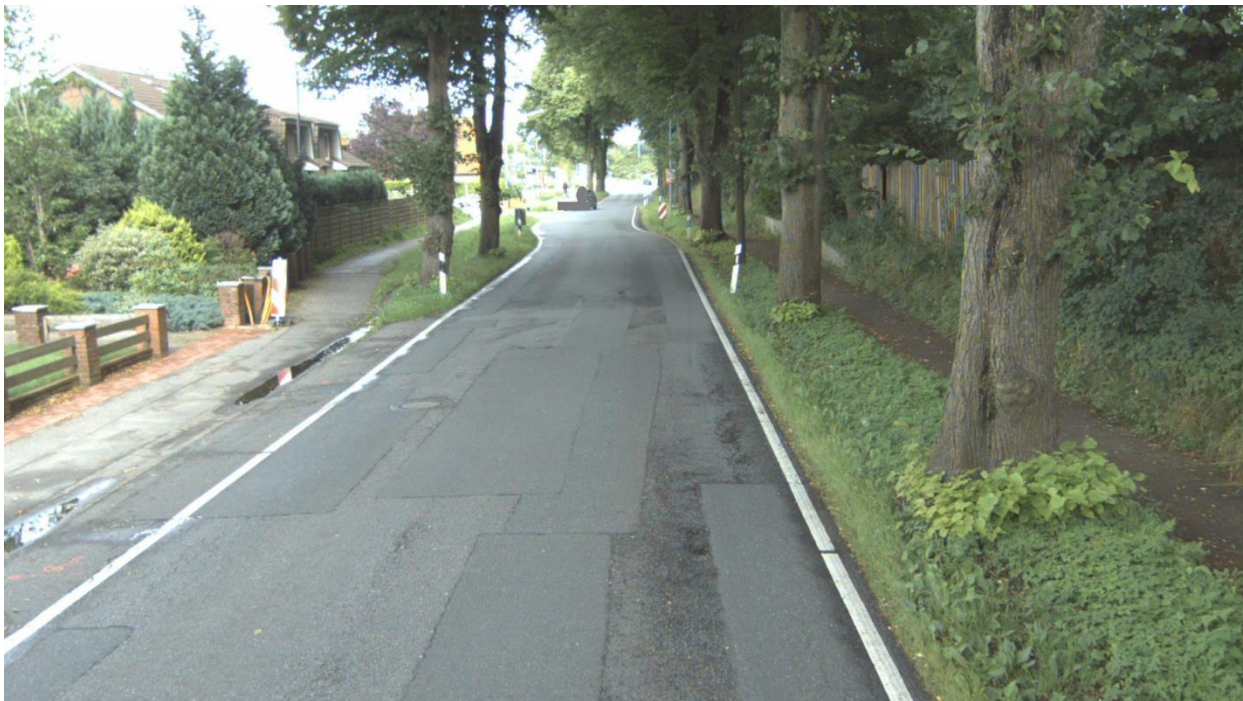
Straße: K75, Abschnitt: 1724010B - 1724002, Station: 540, Lage: R, FS: 1
