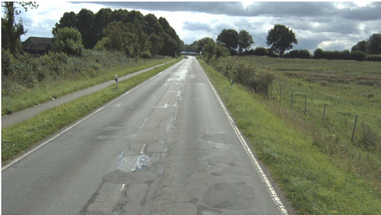
Straße: K49, Abschnitt: 1526009 - 1526022, Station: 830, Lage: R, FS: 1
