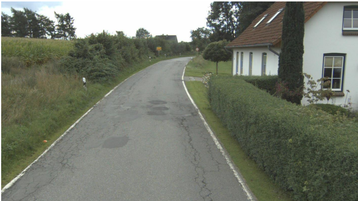
Straße: K92, Abschnitt: 1625004 - 1625006, Station: 742, Lage: R, FS: 1
