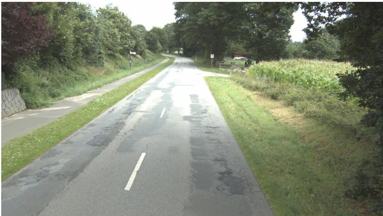
Straße: K26, Abschnitt: 1824009 - 1824008, Station: 480, Lage: R, FS: 1
