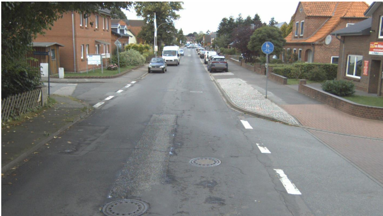
Straße: K99, Abschnitt: 1623031 - 1623013, Station: 5500, Lage: R, FS: 1
