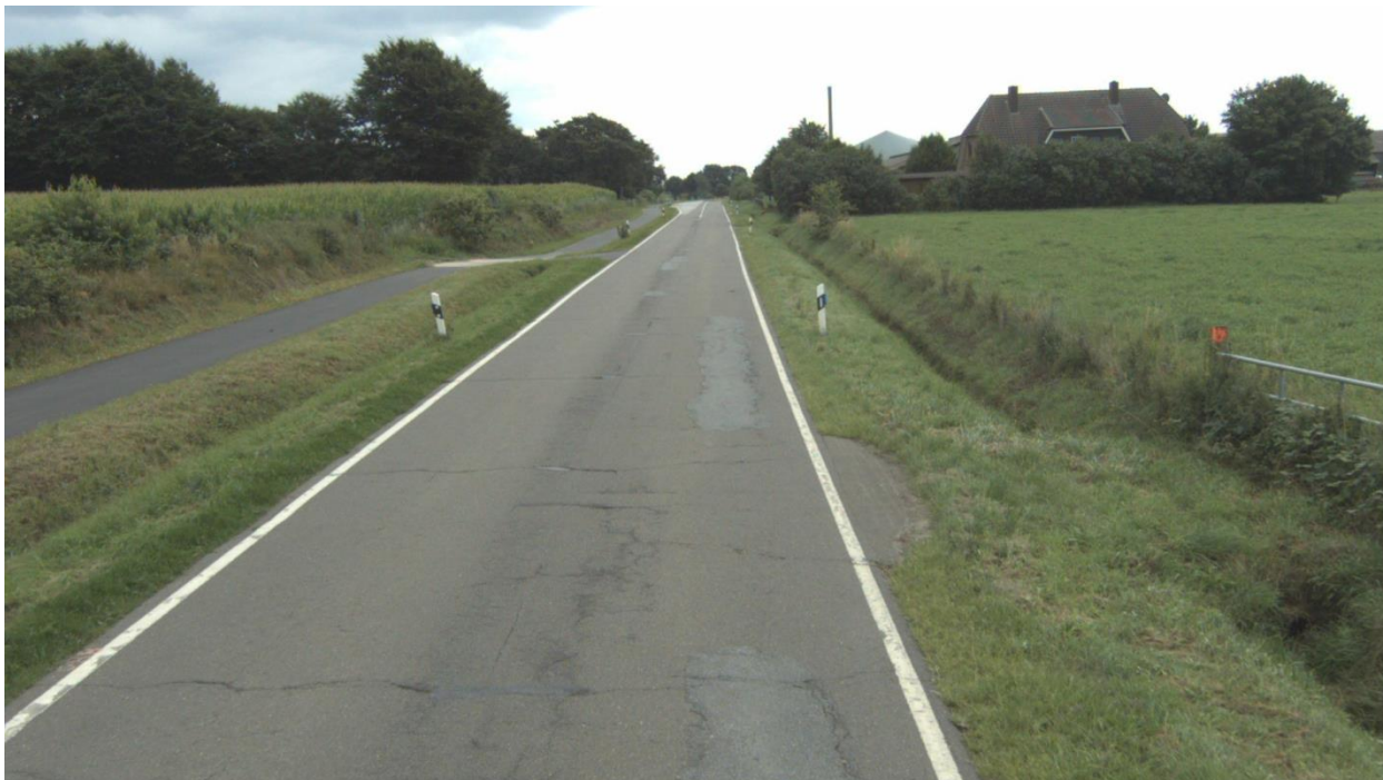
Straße: K43, Abschnitt: 1723016 - 1724013, Station: 1165, Lage: R, FS: 1
