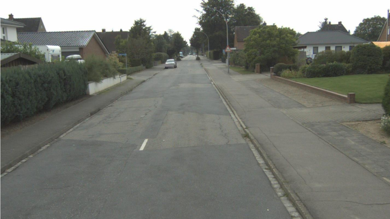
Straße: K8, Abschnitt: 1826005 - 1826013, Station: 175, Lage: R, FS: 1
