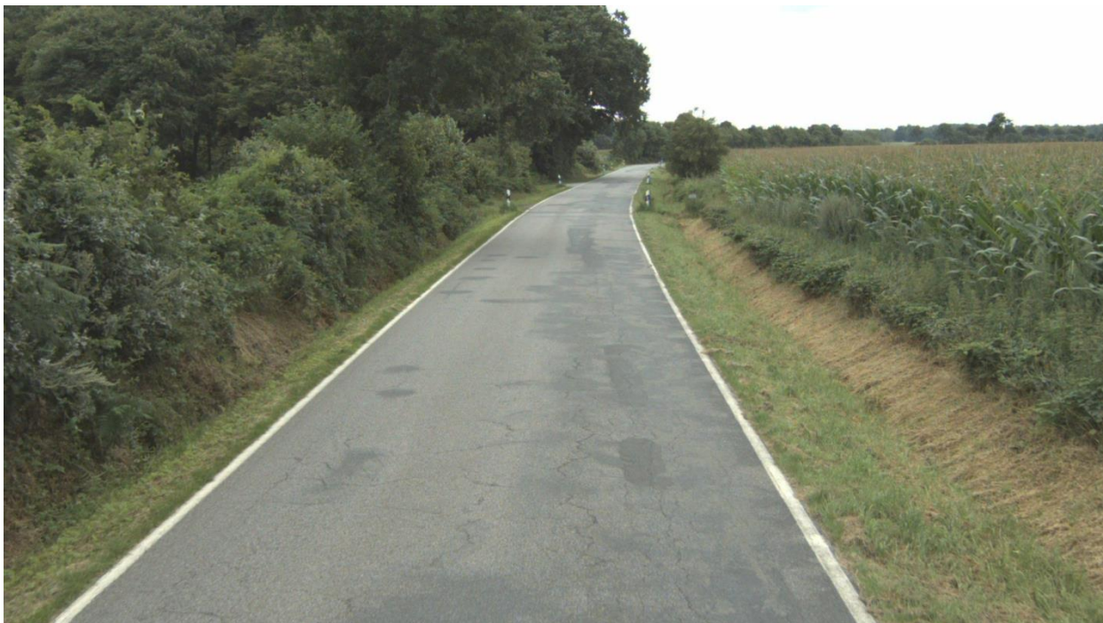
Straße: K26, Abschnitt: 1824009 - 1824008, Station: 7092, Lage: R, FS: 1
