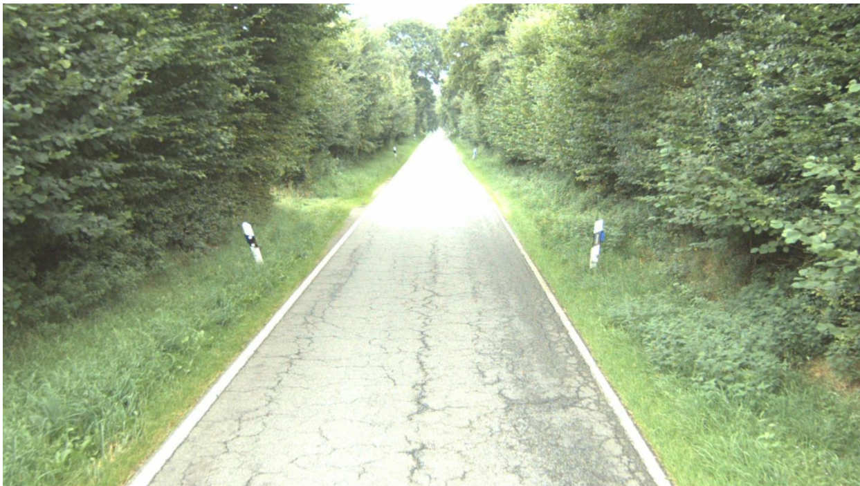
Straße: K36, Abschnitt: 1725008 - 1725005, Station: 3030, Lage: R, FS: 1
