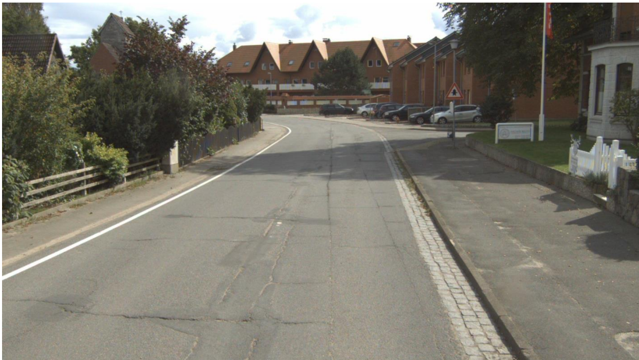
Straße: K58, Abschnitt: 1425004 - 1425007, Station: 173, Lage: R, FS: 1
