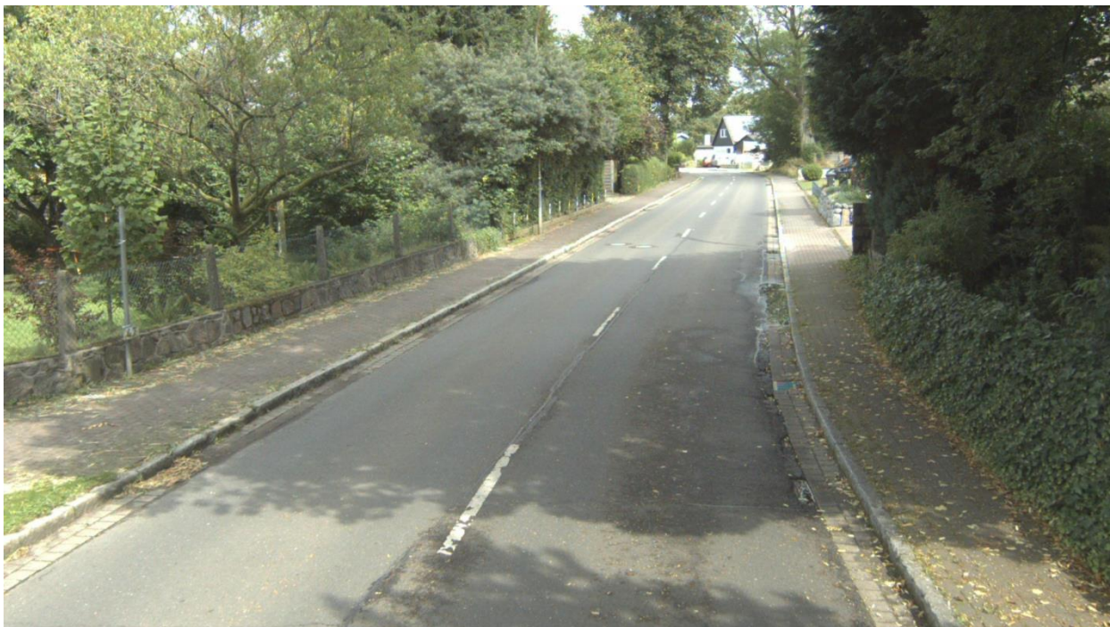
Straße: K75, Abschnitt: 1724002 - 1624020, Station: 1454, Lage: R, FS: 1
