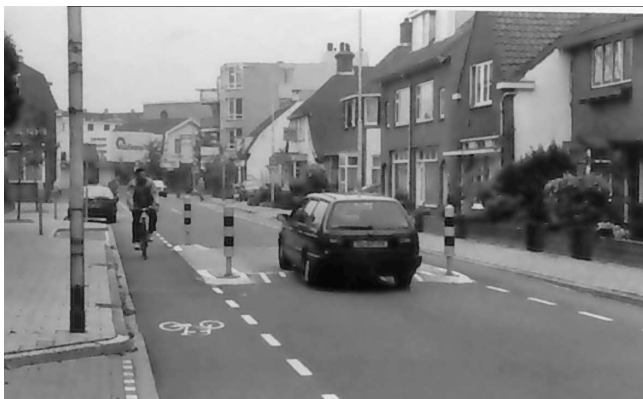
Abbildung 24: Temporeduzierende Schwelle mit Durchlässen für Radfahrer (C.R.O.W., 1995, S. 220)
