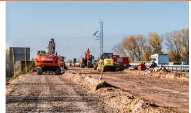
16 Ausbau der BAB 7
