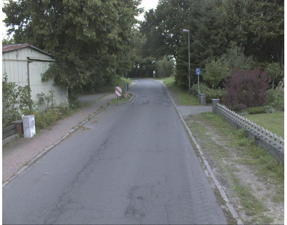
Straße: K0081, Abschnitt: 1924003->1824008, Station: 231, Lage: R, Arbeitsbereich: SH / KStr 2013 - Rendsburg-Eckernförde, Aufnahmedatum: 12.08.2013
