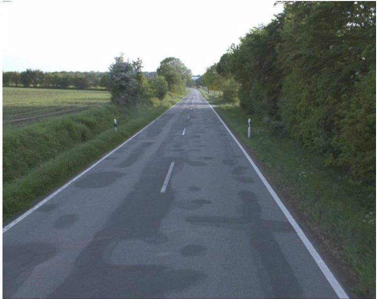
Straße: K0084, Abschnitt: 1824007->1824009, Station: 3384, Lage: R, Arbeitsbereich: SH / KStr 2013 - Rendsburg-Eckernförde, Aufnahmedatum: 30.05.2013
