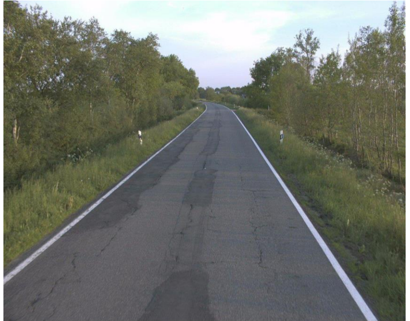
Straße: K0045, Abschnitt: 1724011->1724012, Station: 2752, Lage: R, Arbeitsbereich: SH / KStr 2013 - Rendsburg-Eckernförde, Aufnahme datum: 30.05.2013
