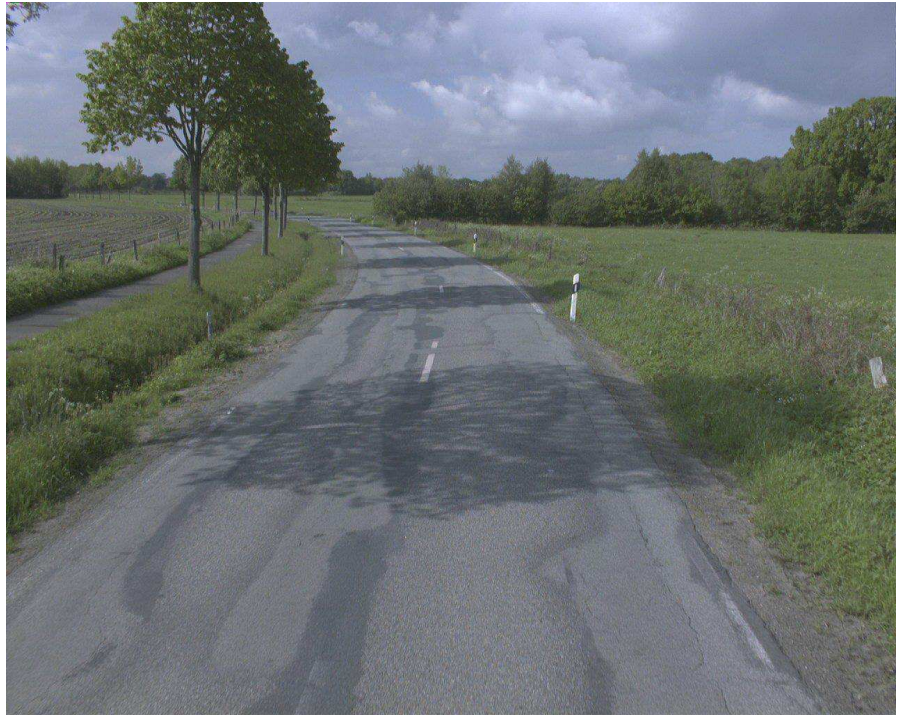
Straße: K0038, Abschnitt: 1923015->1823006, Station: 3922, Lage: R, Arbeitsbereich: SH / KStr 2013 - Rendsburg-Eckernförde, Aufnahmedatum: 27.05.2013
