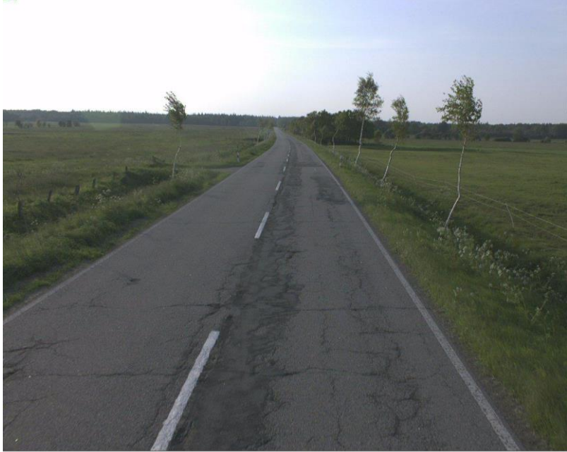
Straße: K0066, Abschnitt: 1824003->1724008, Station: 1370, Lage: R, Arbeitsbereich: SH / KStr 2013 - Rendsburg-Eckernförde, Aufnahmedatum: 30.05.2013
