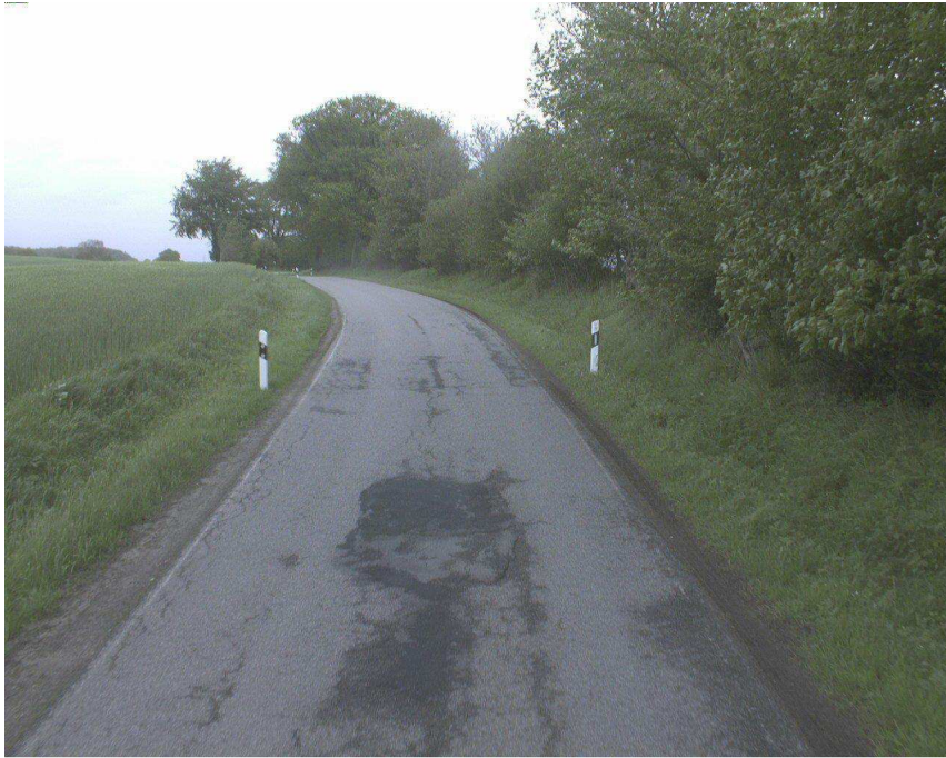
Straße: K0059, Abschnitt: 1424003->1425011, Station: 1162, Lage: R, Arbeitsbereich: SH / KStr 2013 - Rendsburg-Eckernförde, Aufnahmedatum: 22.05.2013
