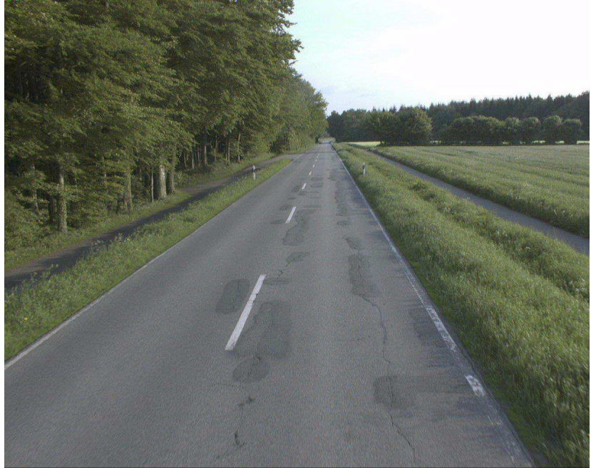
Straße: K0084, Abschnitt: 1824007->1824009, Station: 1510, Lage: R, Arbeitsbereich: SH / KStr 2013 - Rendsburg-Eckernförde, Aufnahme datum: 30.05.2013
