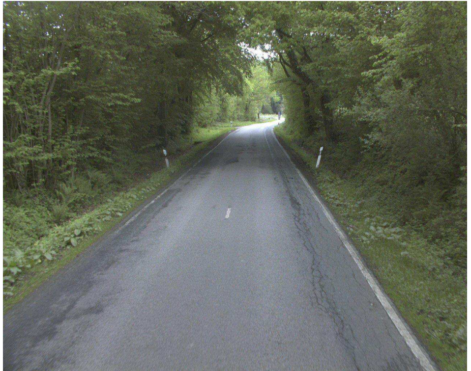
Straße: K0078, Abschnitt: 1624005->1524008, Station: 670, Lage: R, Arbeitsbereich: SH / KStr 2013 - Rendsburg-Eckernförde, Aufnahmedatum: 27.05.2013
