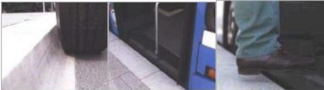
Abb. 29: niederflurgerechter Profil-Bordstein (aus [www.nullbarriere.de](http://www.nullbarriere.de))
