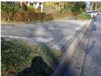
Abb. 30: geräumige Hochbord-Haltestelle mit Bodenindikatoren (in Kronshagen, auch Abb. 31)
