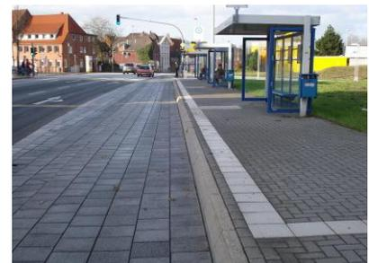
Abb. 35/ Abb. 36: Hochbord und Bodenindikatoren bei beengten Platzverhältnissen (in Eckernförde) – Aufmerksamkeitsfeld fehlt hier
