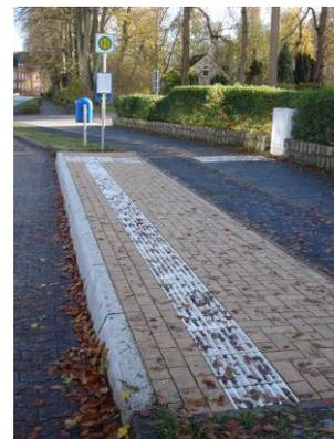
Abb. 32: Hochbord-Haltestelle mit Bodenindikatoren in Eckernförde (mit nachrangiger Nachfrage)
