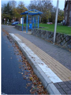
Abb. 35/ Abb. 36: Hochbord und Bodenindikatoren bei beengten Platzverhältnissen (in Eckernförde) – Aufmerksamkeitsfeld fehlt hier
