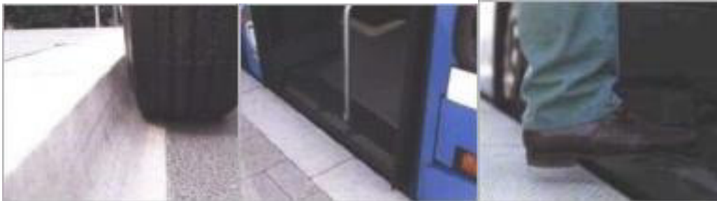
Abb. 29: niederflurgerechter Profil-Bordstein (aus www.nullbarriere.de )
