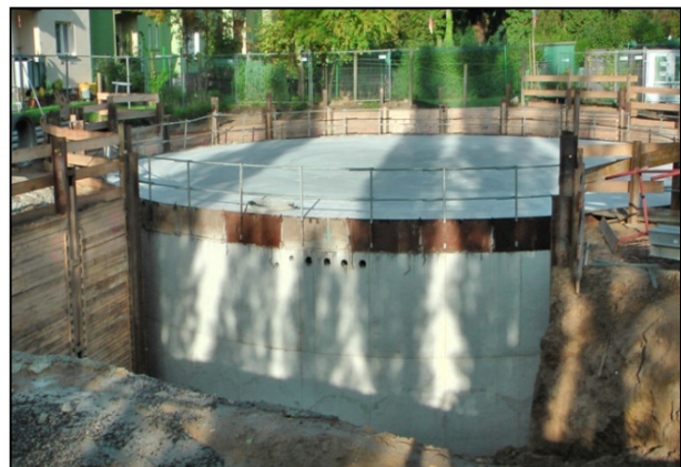
Saisonalere, in die Erde eingelassener Speicher im Rohbauzustand. Nach Fertigstellung ist der Speicher vollständig von Erdreich überdeckt und nicht mehr sichtbar.
