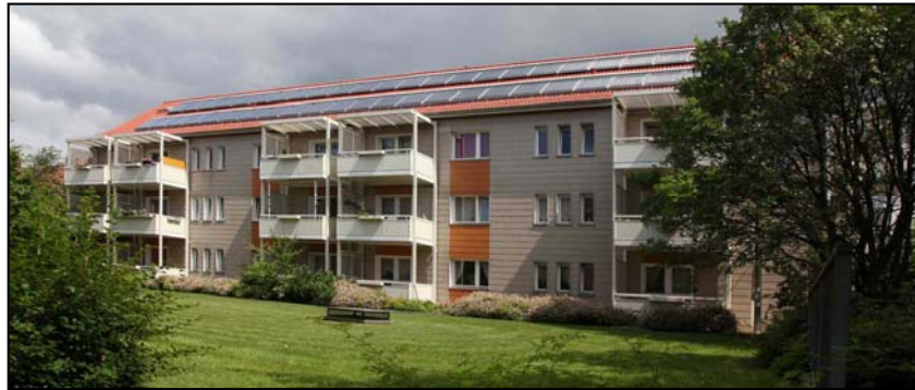
Große solarthermische Anlage auf Mehrfamilienhaus in Hamburg-Harburg
