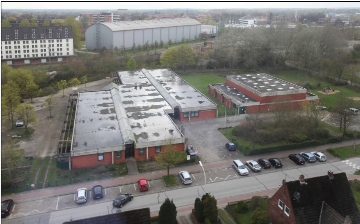
Blick auf das Untersuchungsgebiet von Osten: Im Vordergrund die Heinrich-de-Haan-Schule, links im Hintergrund Lagerhalle und ehem. Mannschaftsgebäude der Bundeswehr und rechts das BBZ am Nordostseekanal; das Bahngelände in der oberen Bildmitte bildet eine Zäsur
