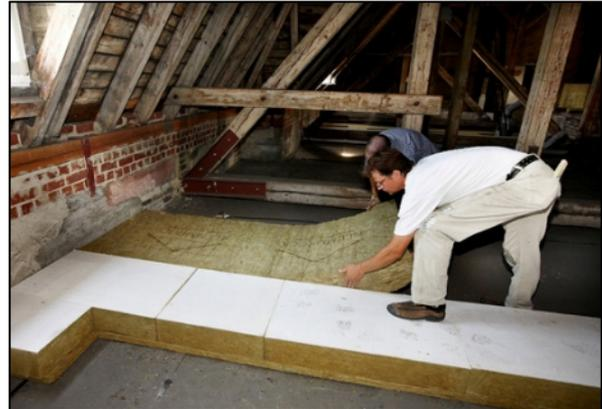
Dargestellt sind Ausführungsbeispiele für die Dämmung des Steildaches (links)<sup>16</sup> und der obersten Geschossdecke (rechts)<sup>17</sup>. Die Maßnahme an der obersten Geschossdecke ist auch bei stadtbildprägenden oder denkmalgeschützten Gebäuden problemlos durchführbar. Eine Steildachdämmung erfordert schon etwas mehr ästhetisches Einfühlungsvermögen bei Bauteilanschlüssen und Materialwahl für die Deckung.
