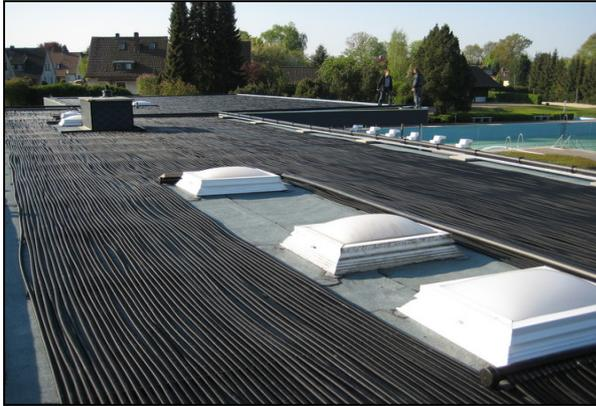
Diese zweite Abbildung zeigt eine Großanlage auf einem Flachdach aus lose verlegtem Riffelrohr.
