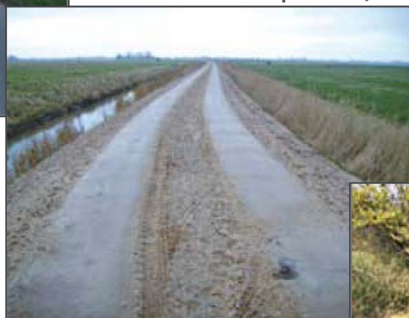
Asphalt / Beton Spurbahnen
