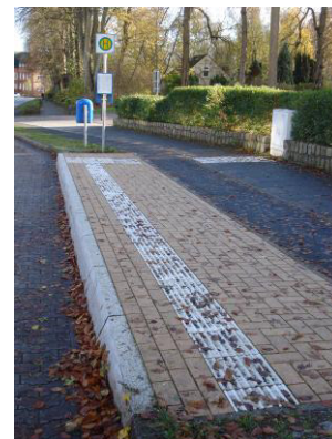
Abb. 32: Hochbord-Haltestelle mit Bodenindikatoren in Eckernförde (mit nachrangiger Nachfrage)
