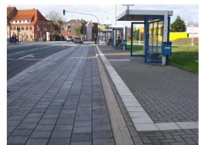
Abb. 32: Hochbord-Haltestelle mit Bodenindikatoren in Eckernförde (mit nachrangiger Nachfrage)
