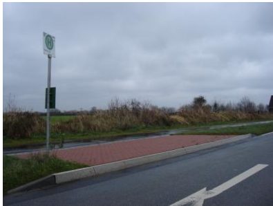
Abb. 37/ Abb. 38/ Abb. 39: Wenig frequentierte Haltestellen im ländlichen Raum mit kontrastreichem Hochbord sowie (rechts/Abb. 39) Bodenindikatoren und niedriger Aushanghöhe (alle im Gemeindegebiet Schinkel)
