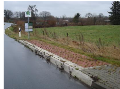
Abb. 37/ Abb. 38/ Abb. 39: Wenig frequentierte Haltestellen im ländlichen Raum mit kontrastreichem Hochbord sowie (rechts/Abb. 39) Bodenindikatoren und niedriger Aushanghöhe (alle im Gemeindegebiet Schinkel)
