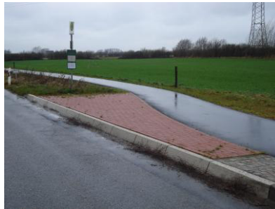
Abb. 37/ Abb. 38/ Abb. 39: Wenig frequentierte Haltestellen im ländlichen Raum mit kontrastreichem Hochbord sowie (rechts/Abb. 39) Bodenindikatoren und niedriger Aushanghöhe (alle im Gemeindegebiet Schinkel)
