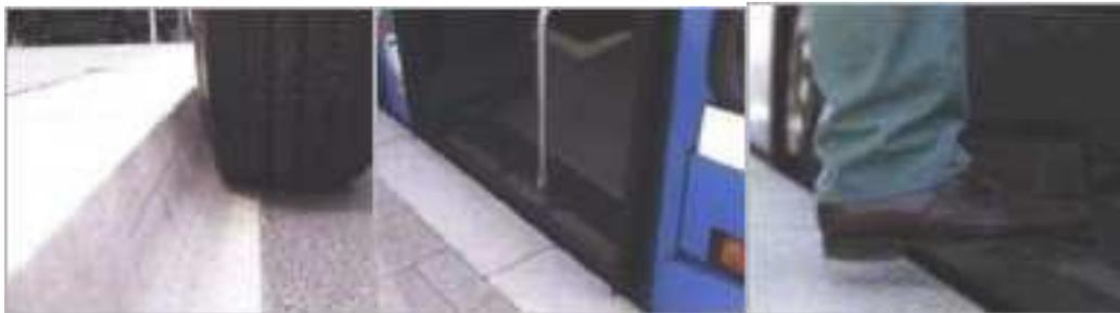
Abb. xy: niederflurerechter Profil-Bordstein (aus [www.nullbarriere.de](http://www.nullbarriere.de))
