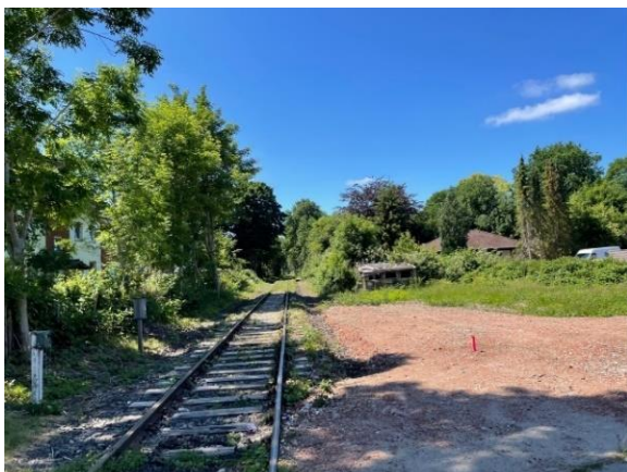
Abbildung 10 Bahnübergang in der Schleswiger Chaussee
