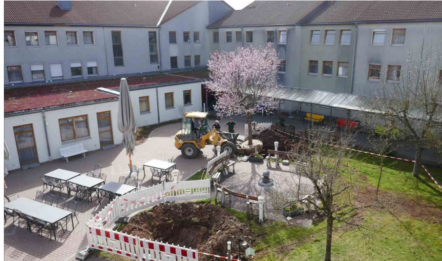
Abbildung 11: Dachbegrünung als natürliche Klimaanlage im AWO Sozialzentrums Erlangen (Foto: AWO Sozialzentrum Erlangen )
