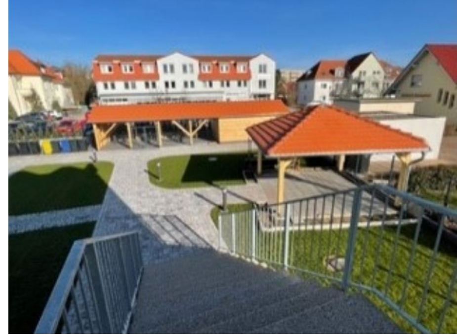
Abbildung 15: Pavillon als Sonnenschutz (Foto : ASB OV Luckau/Dahme e.V. )
