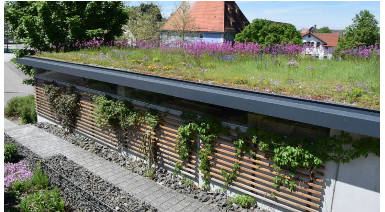
Abbildung 16: Grün auf Dach und Fassade (Foto: BuGG, G.Mann)
